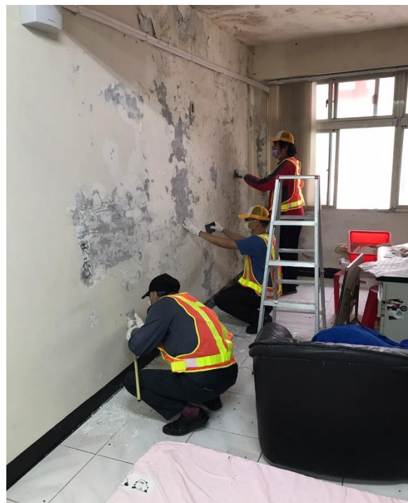
社勞人處理屋內牆上嚴重的壁癌、進行油漆以及水電維修與整理室廳走道的雜物
